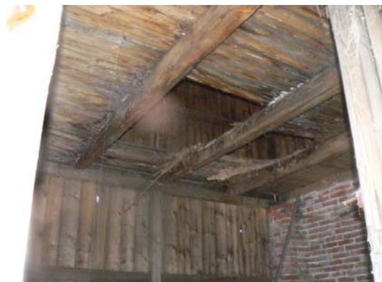
SHNILÝ STROP STODOLY VE DVOŘE
