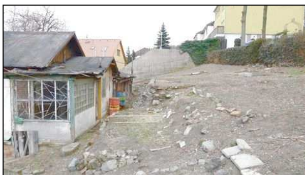
pohled východní - na západní hranici opěrná zeď
