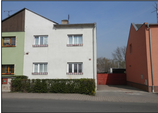
Pohled z Chomutovské ulice
